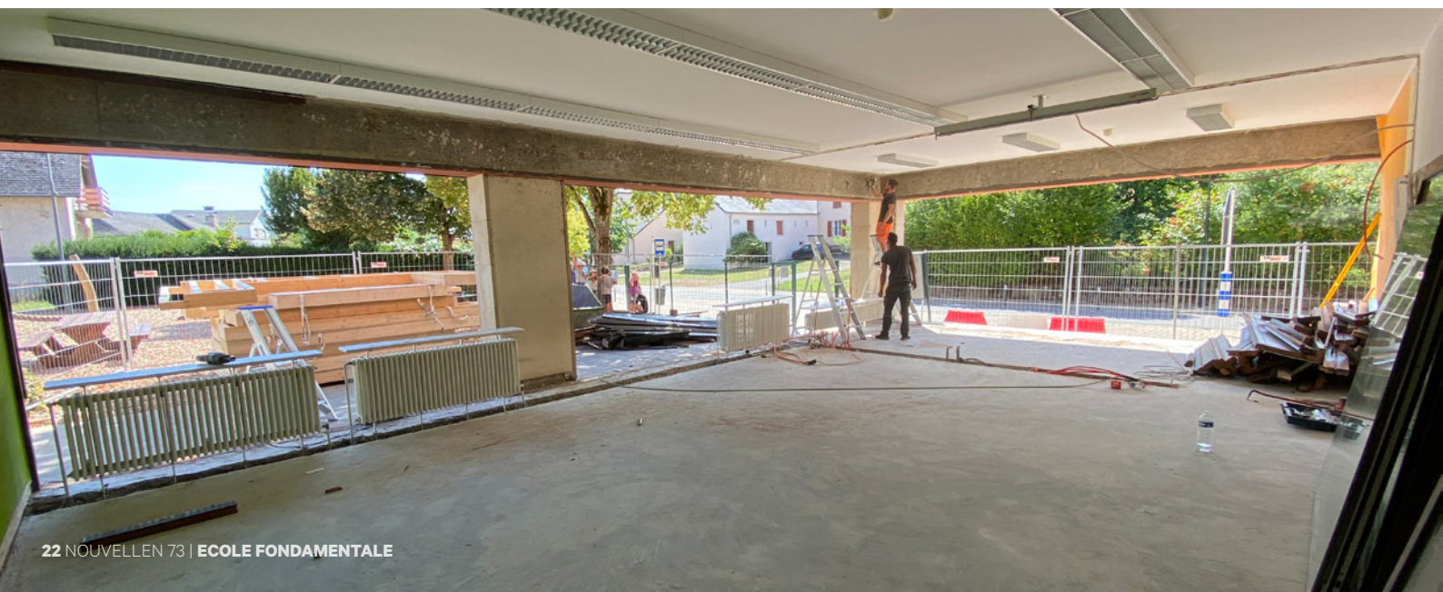
Rénovation école / Renovierungsarbeiten Schule (côté cour / Rue de l'Eglise)
